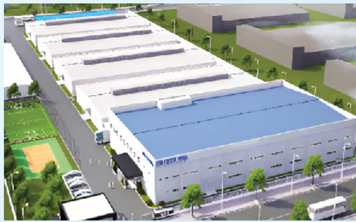
NHÀ MÁY CPRO CPRO FACTORY
