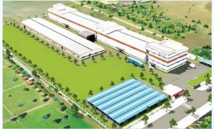
NHÀ MÁY WOOSUNG ELECTRONICS WOOSUNG ELECTRONICS FACTORY
