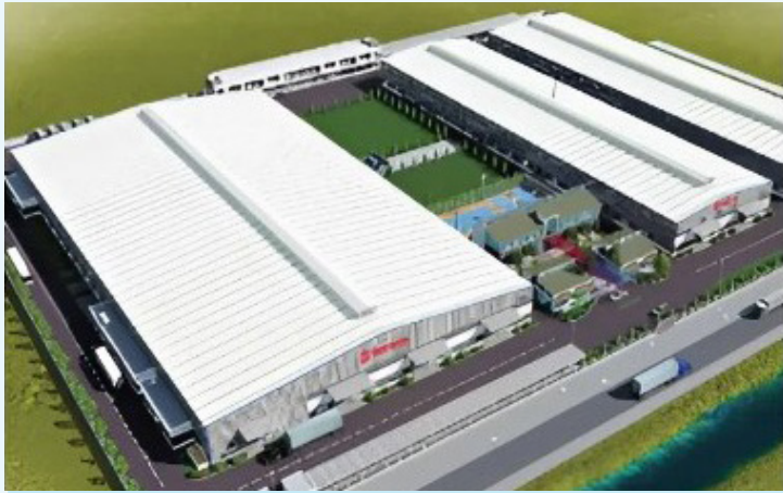
NHÀ MÁY SƠN HÀ SON HA FACTORY
